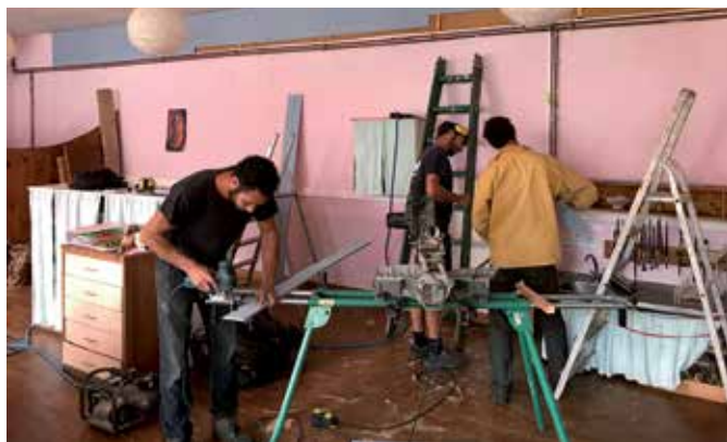
Un chantier d'isolation réalisé par les parents au Jardin d'enfants en 2022.
